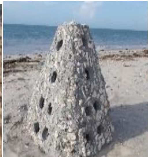
Modèle pyramidale de support pour le récif artificiel. MPEB 2022
